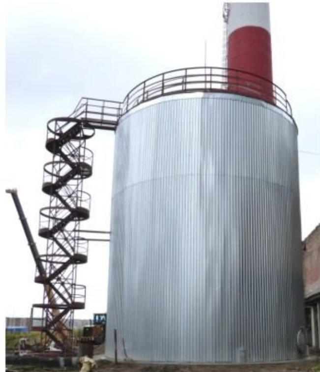
Баки аккумуляторы вертикального типа обычно имеют большой объем. Эти изделия создаются из различных металлических сплавов. В их конструкцию входит днище, стенки, самонесущая или каркасная крыша с ограждением, площадка для обслуживания и лестница. Лестница на бак - многомаршевая, шахтная.
