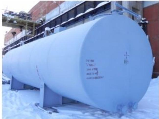
Проектирование, изготовление, монтаж и эксплуатация горизонтальных наземных резервуаров РНГ осуществляется в соответствии с:
